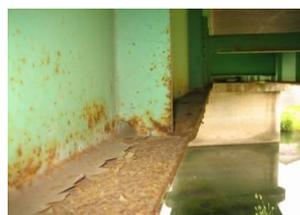
写真-1 鋼桁の腐食
