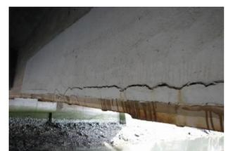
写真-2 コールト桁のひび割れ
