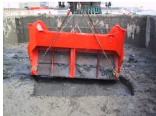
図-2 水平掘削状況 (4m 3 級)
