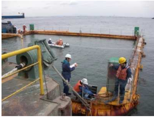
図-11 グラブ枠内での濃度分布観測状況
