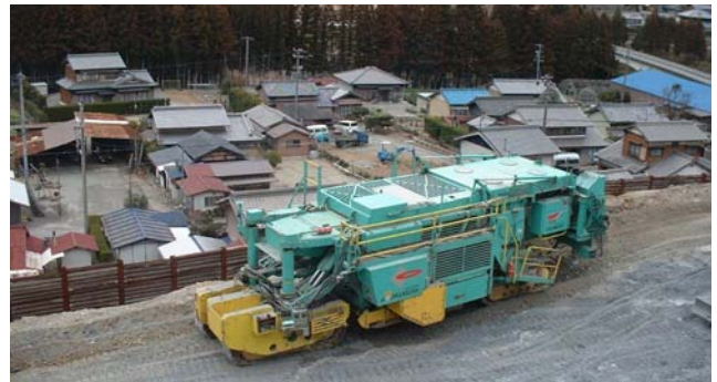
写真-2 粉塵対策（集塵機）
