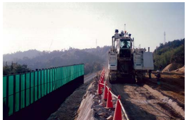
写真-8 施工状況
