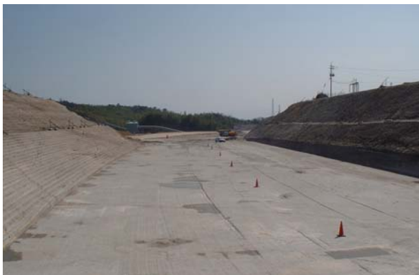
写真-11 完成状況
