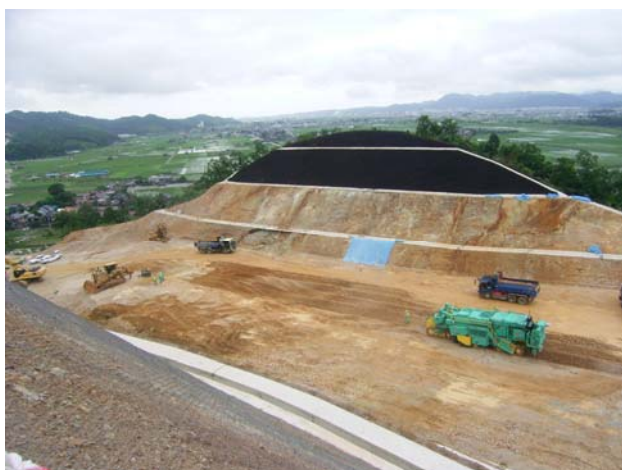
写真-14 施工状況
