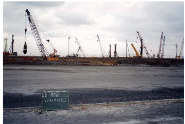
写真-7 完成状況
