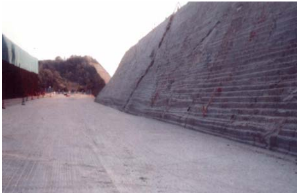
写真-9 完成状況
