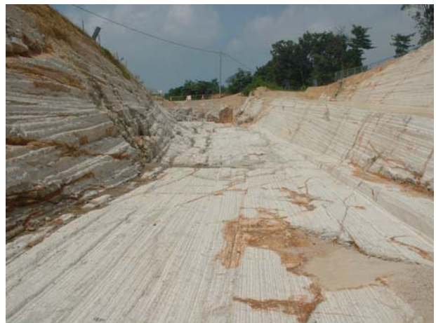
写真-13 完成状況
