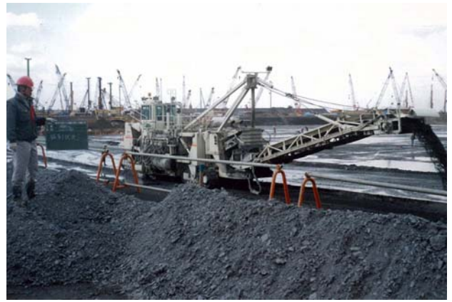
写真-6 施工状況
