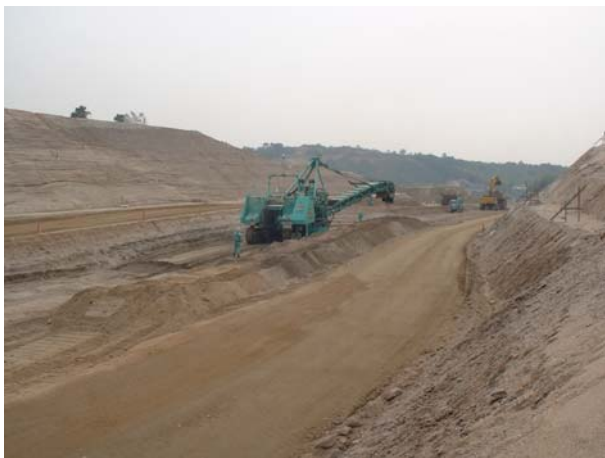
写真-10 施工状況
