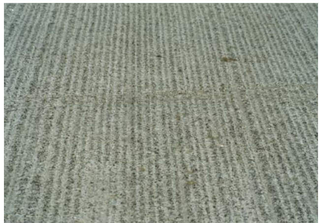
写真-4 基面の仕上がり状況
