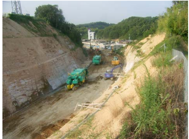
写真-12 施工状況
