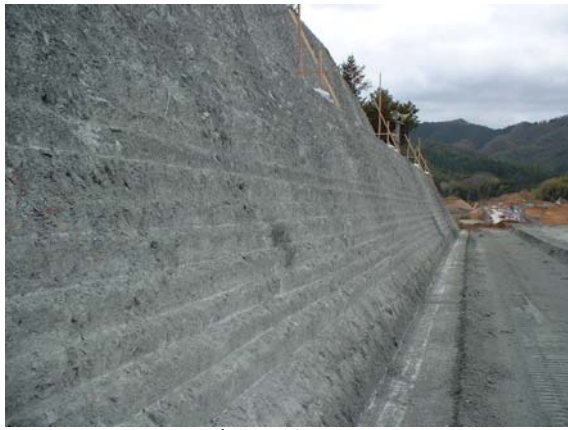
写真-5 法面の状況
