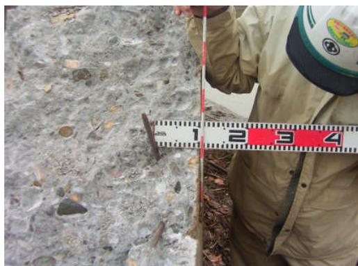
写真-6 撤去部断面(鉄筋断面)
