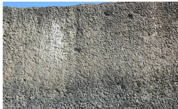
写真-5 旧神戸堰表面(摩耗状況:表面が洗われているが凍害による骨材の流出などは見受けられない)
