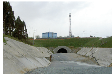
図5 トンネル周辺状況
