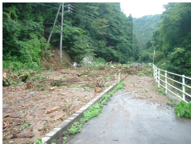
写真-3 被災状況3
