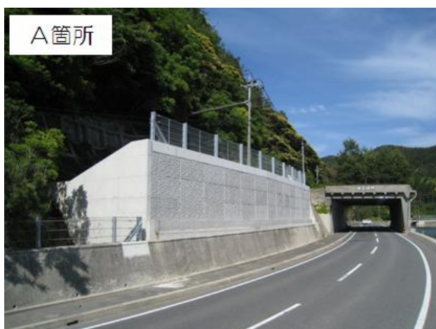
写真-6 完成写真
