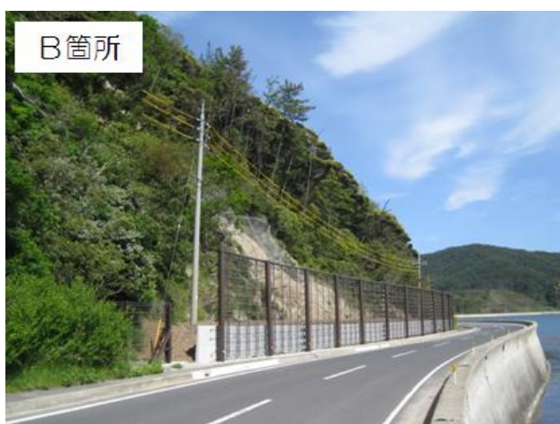
写真-7 完成写真
