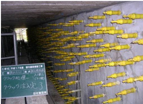
図-3 表面漏出防止工
