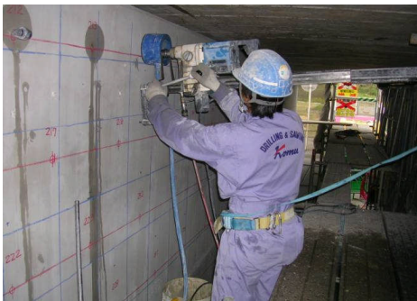
図-4 削孔工(ダイヤモンドコアドリル)
