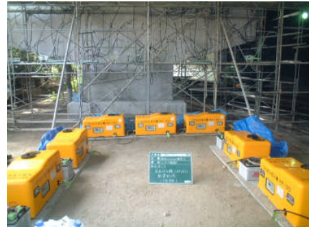
図-6 海田高架橋(2004年施工)
