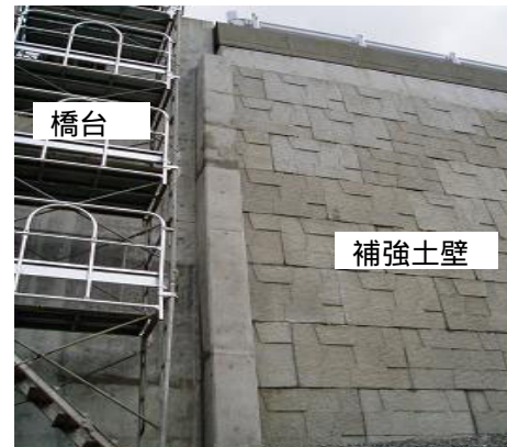
写真 - 14 工事完成後の状況
