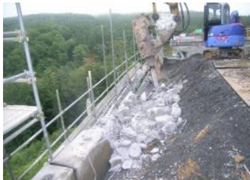
写真 - 11 天端笠コンクリートの取壊し
