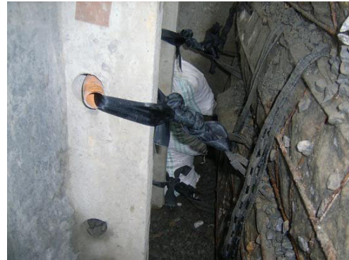
写真 - 13 引抜け防止材の連結
