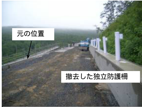
写真 - 10 撤去した独立防護柵
