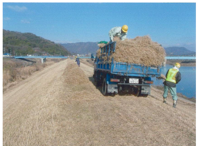
写真-3 積載状態
