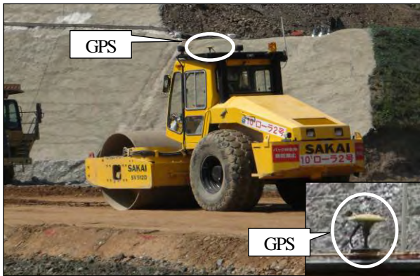
写真-5 締固め作業状況 (コア)
