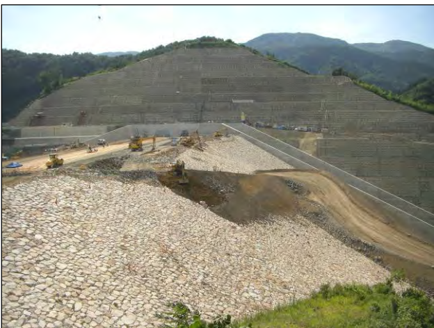
写真-1 盛立工施工状況
