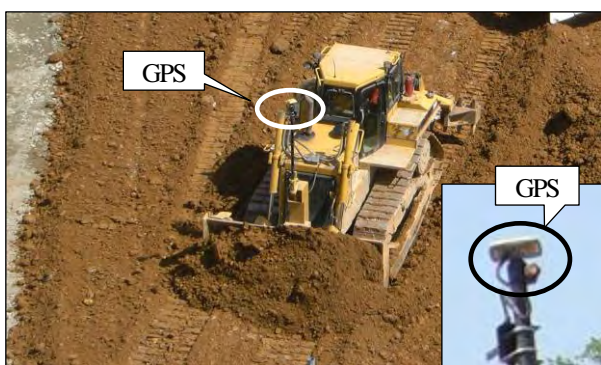
写真-3 まき出し作業状況（コア）
