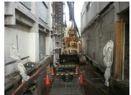
図 12 連続山留壁施工状況
