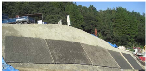
写真-8 施工直後の法面の状況
