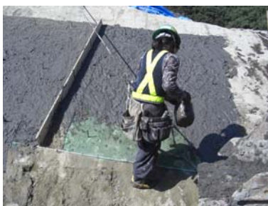
写真-7 施工状況の一例
