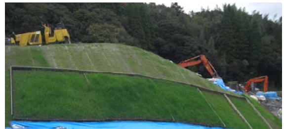
写真-9 施工2か月後の法面の緑化状況
