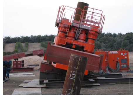
写真6 斜杭の施工状況
