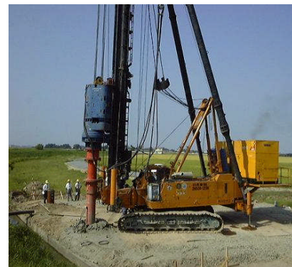
写真-4 回転杭の施工例（杭頭回転方式）
