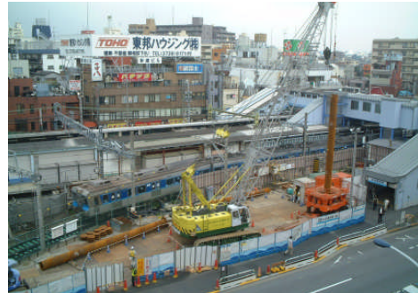
写真7 狭隘地における施工状況
