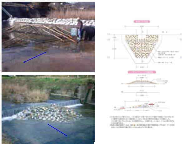
図-2 榎野川魚道とその施工図面
