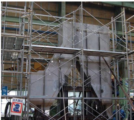
写真-2 底部取水管組立状況
