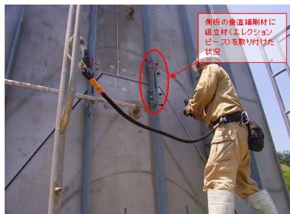
写真-8 据付・溶接準備状況
