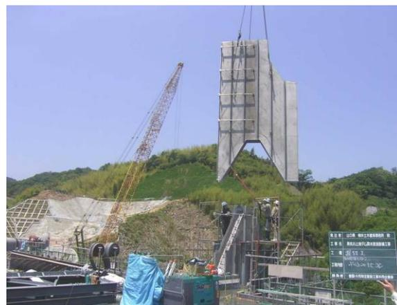
写真-7 選択取水管吊り込み状況
