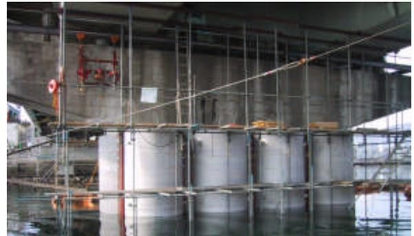
写真-2 鋼製ピット設置状況
