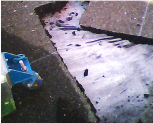
写真-8 測定箇所（一般写真）
