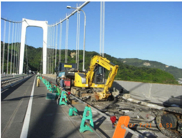
写真-7 舗装発生材の積み撤去状況
