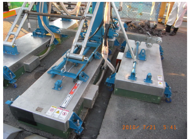
写真-4 I H式加熱状況（加熱パネル）
