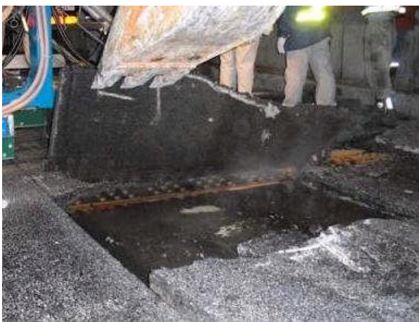
写真-10 添接板部の舗装剥ぎ取り状況事例
