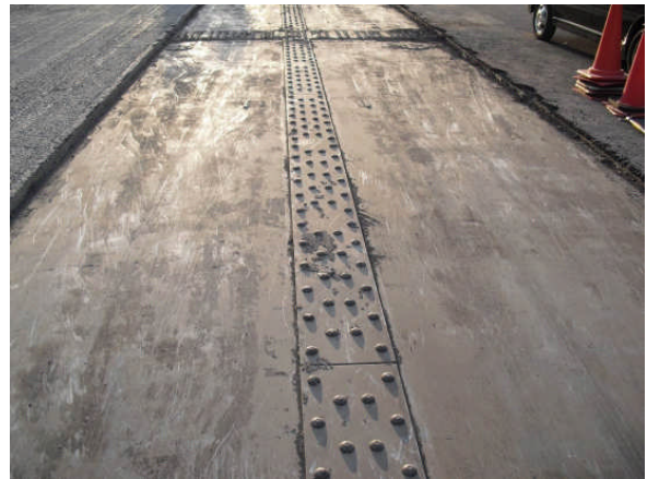
写真-11 剥ぎ取り後の鋼床版面の事例
