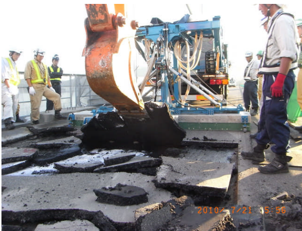
写真-6 舗装撤去状況
