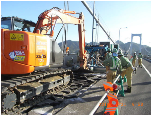
写真-5 舗装撤去状況全景
