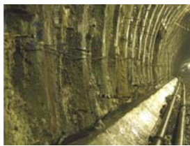
注入完了後の坑内状況
