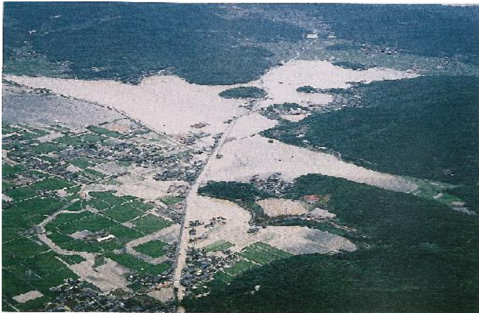
千田川の浸水状況 (建設省岡山河川工事事務所提供)
