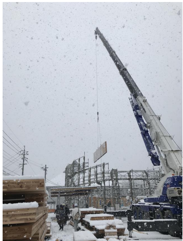
写真-6 雪の中でのCLTパネルの吊り込み
