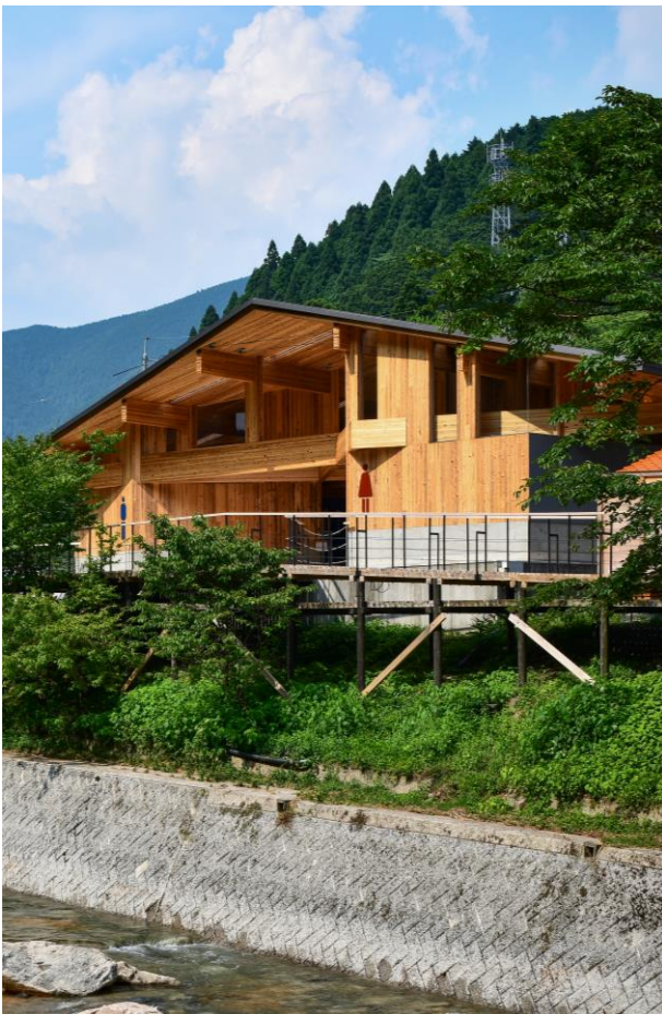
写真-7 「道の駅あわくらんどトイレ」外観
