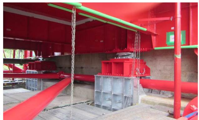
図-10 ニーブレースと下弦材接合部 端支点部対策工
