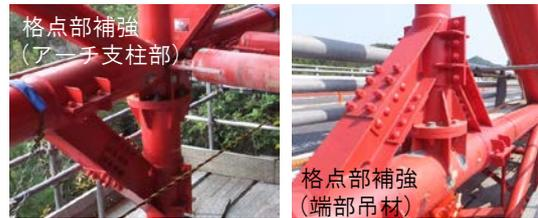
図-7 応急対策工
