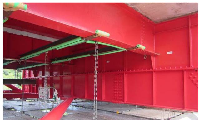
図-11 ニーブレースと下弦材接合部 アーチ支柱部対策工
