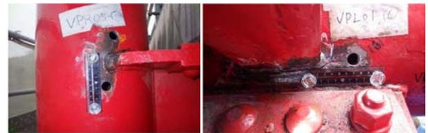
写真-1 亀裂状況（ストップホール削孔後）
