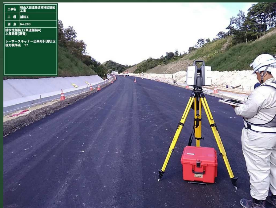
上層路盤（再生As安定処理）
