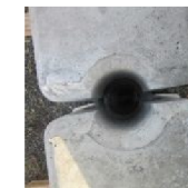
製品の設置後に上から見た状
