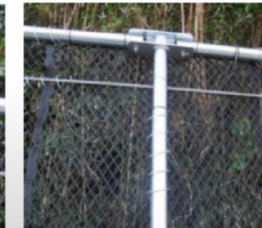
支柱のネットジョイント
