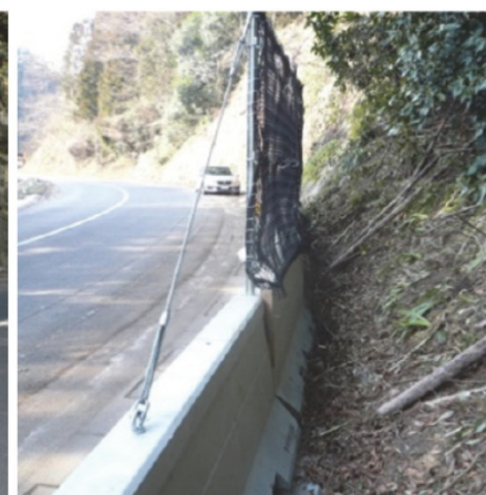
施工後：落石混じり土砂を捕捉
