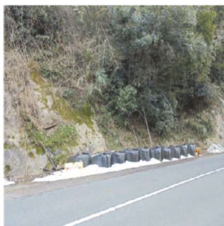
施工前：大型土のう
