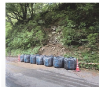
大型土のう対処事例
