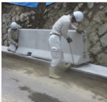
基礎擁壁に支柱を建て込んだ状態
