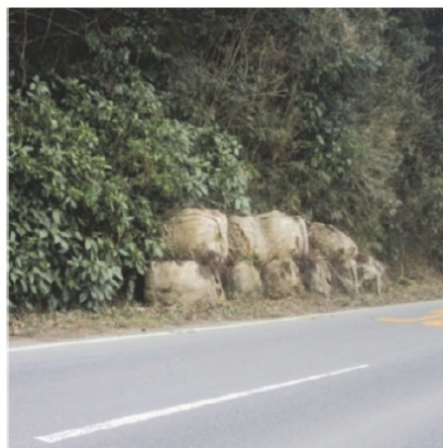
施工前：大型土のう
