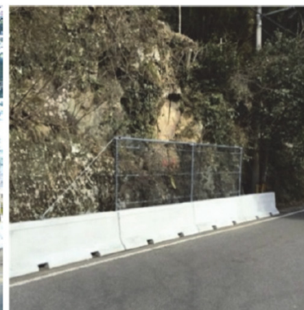
岩盤の剥離場所に設置
