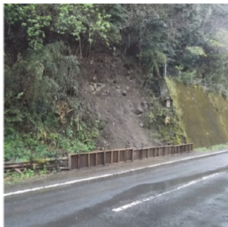
施工前：崩壊現場に仮設の木柵
