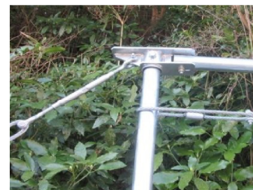
トップジョイントとPSターンバックルを接続した状態
