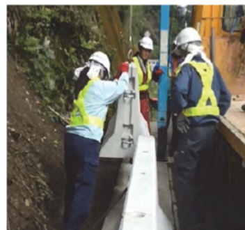
基礎擁壁に支柱を建て込んだ状態
