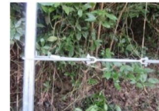
横ロープ+SRターンバックル
