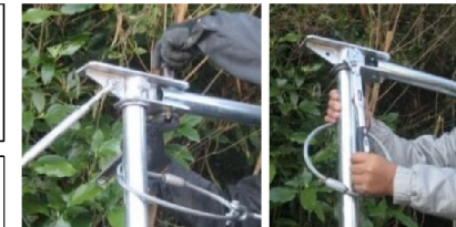
トップバーとトップジョイントを連結して、ボルトを差し込んで、トルクの締め付け荷重を確認している状態
