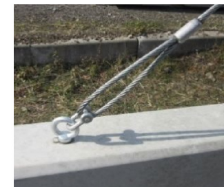
アイボルトとシャックルと斜ロープを接続した状態
