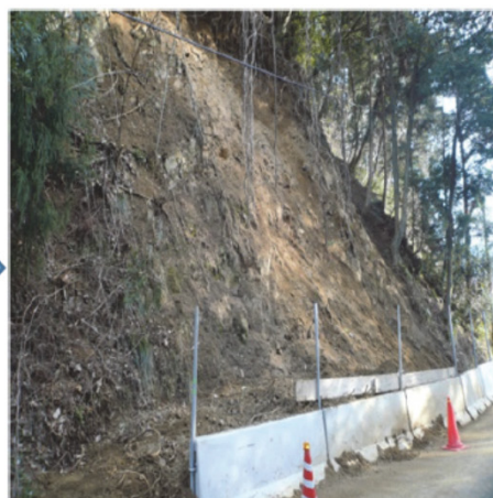
施工後：崩壊土砂を捕捉
