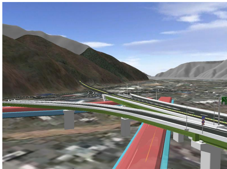
Dランプ橋全景 (Dランプ部拡大)
