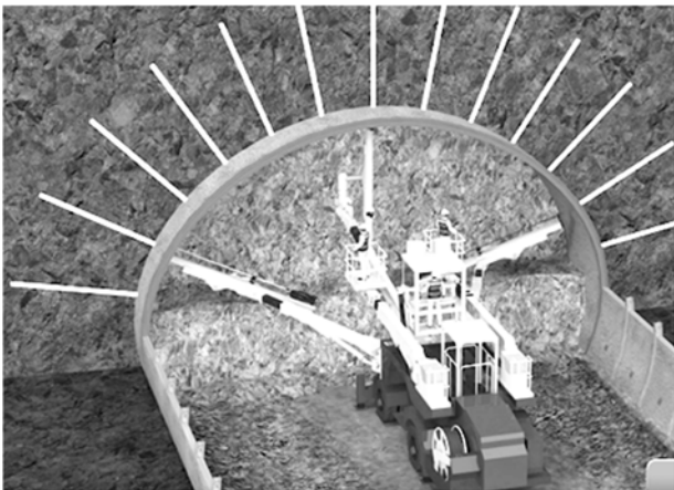
図-3 ロックボルト打設
