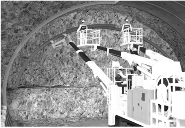
図-1 鋼製支保工建込み
