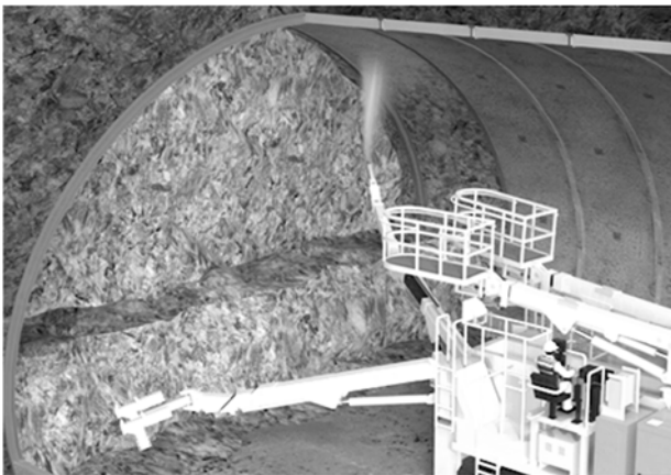
図-2 吹付けコンクリートの施工
