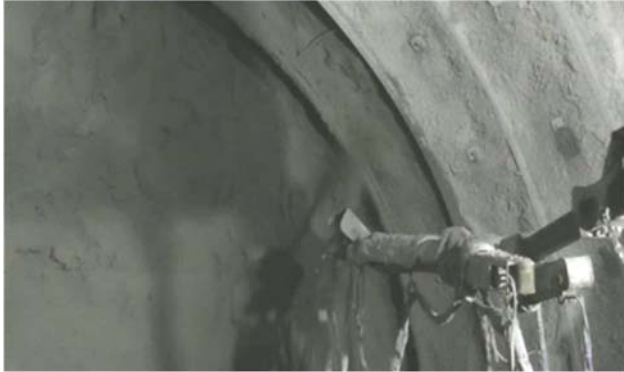
写真-2 吹付け作業状況
