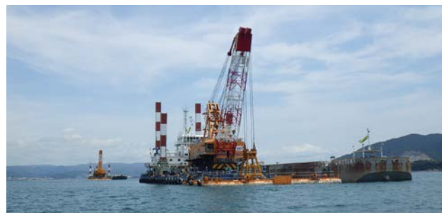
写真-1 浚渫状況
