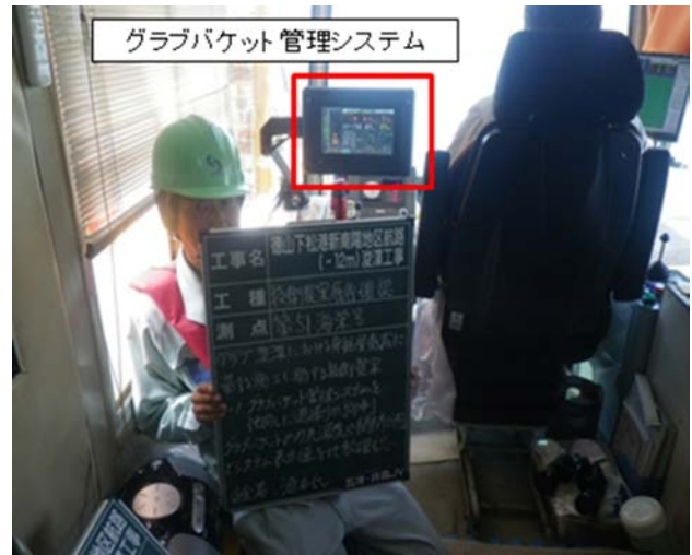
写真-5 浚渫状況
