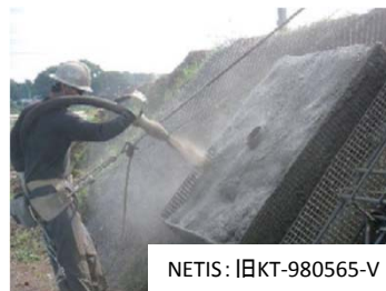
高所・長距離吹付け施工 可能なモルタル吹付工
