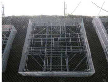
半プレキャストの 組立方式受圧板
