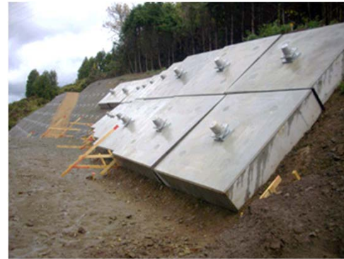
現場打ちコンクリート受圧板
