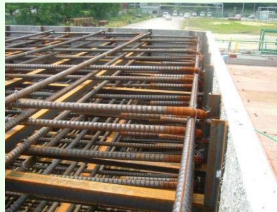
配筋・支保状況
