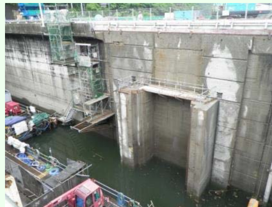
取水塔設置前状況
