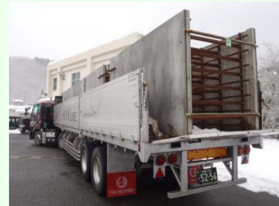
函体搬出(トラック)
