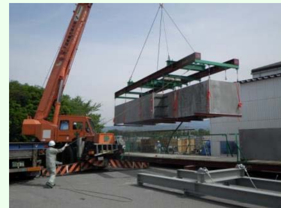
取水塔函体組立・搬出(工場)
