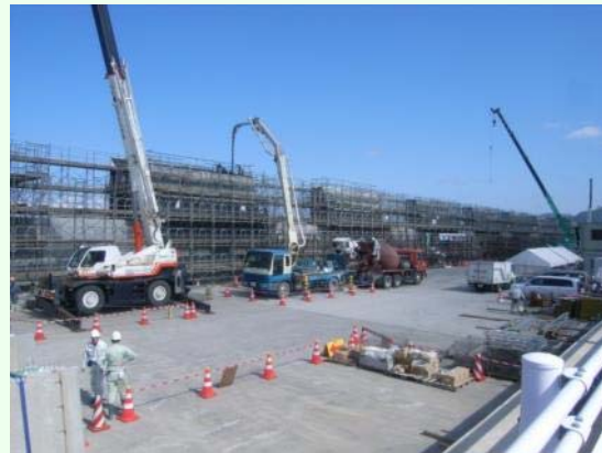
全体施工状況
