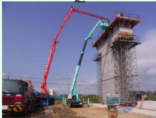
躯体コンクリート打設
