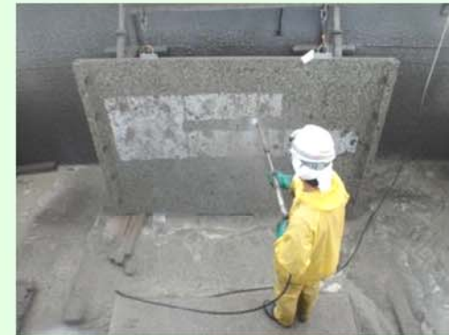
洗出し状況(平板)
