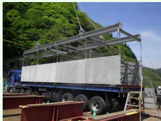
函体搬入(トラック)
