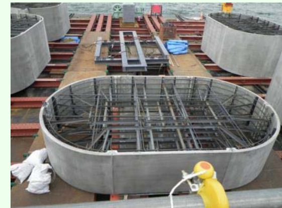
函体組立状況
