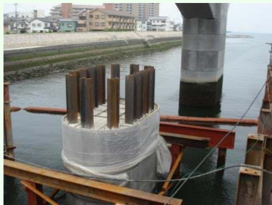
函体施工状況
