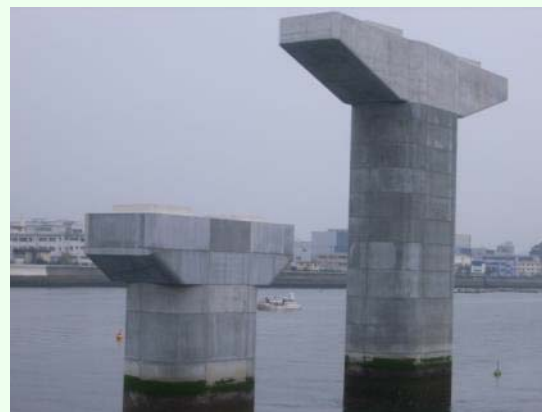
柱部・梁部施工完了(左側)
