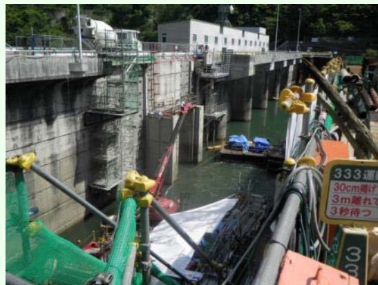
取水塔設置前状況
