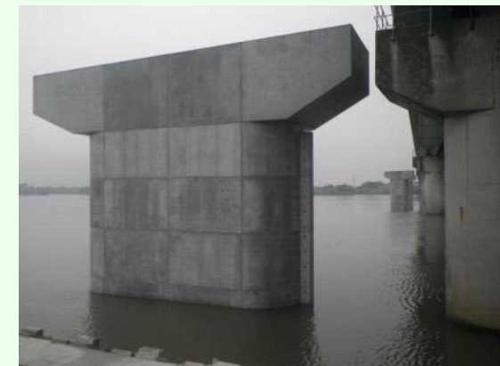
柱部・梁部施工完了（左側）
