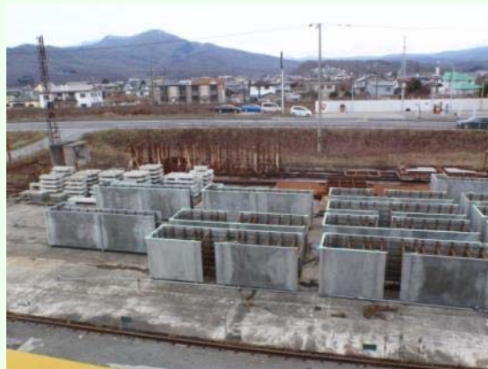
取水塔函体組立(工場)
