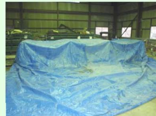
(蒸気)養生状況
