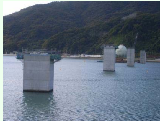
全体施工状況
