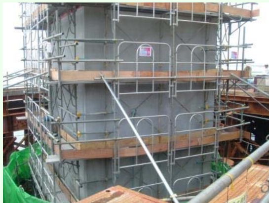
函体施工状況
