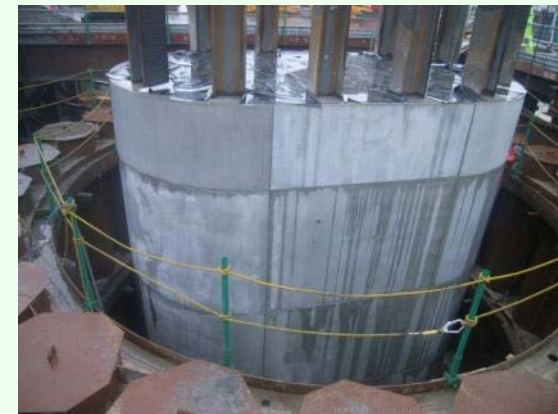
函体施工状況
