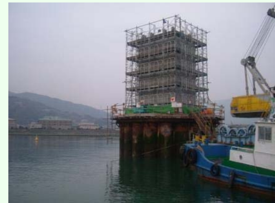
函体施工状況
