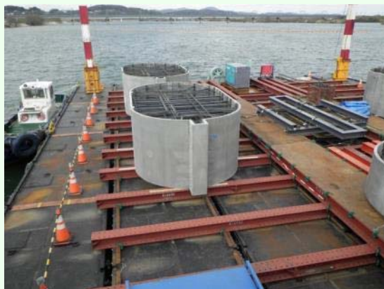
函体組立状況
