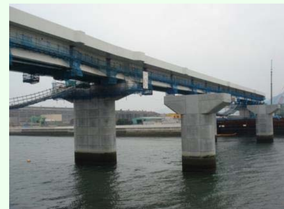
柱部・梁部施工完了(右側)
