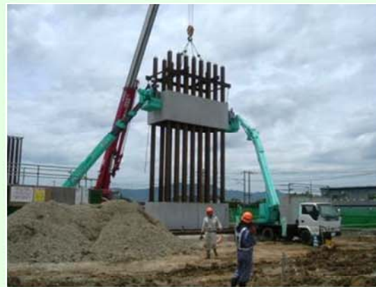
柱部函体施工
