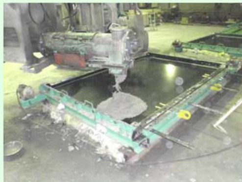
コンクリート投入状況
