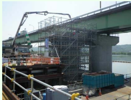
梁部施工状況
