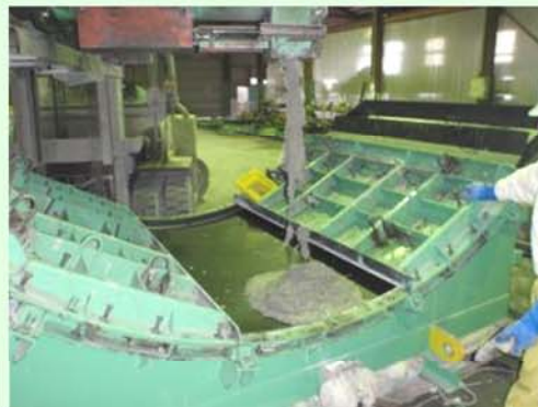
コンクリート投入状況
