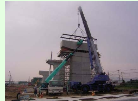
梁部組立函体施工
