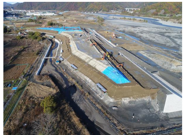
写真-2 簡易ドローン測量（盛土工で検証）
