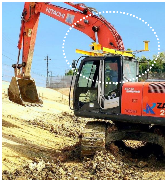
写真-4 システム重機搭載状況
