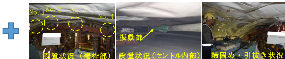
引抜き式バイブレータ4本による締固め
