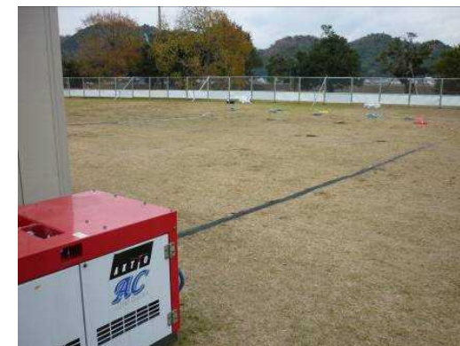
空気注入状況
