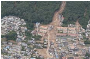
③土砂災害の状況 (広島県広島市)
