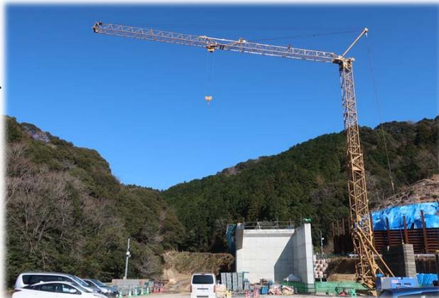
従来の「移動式クレーン」による施工と、比較し「定置式水平ジブクレーン」の活用方法を評価・検討
