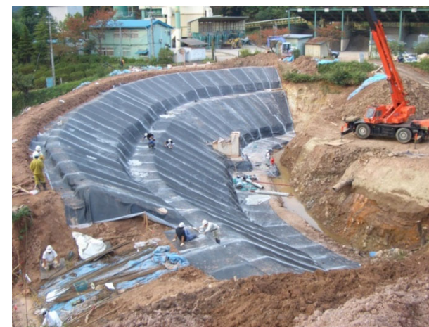
ベントナイトシート敷設状況
