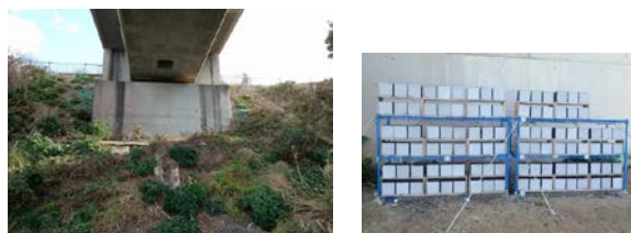
写真-1 試験体暴露場所(角島大橋)
