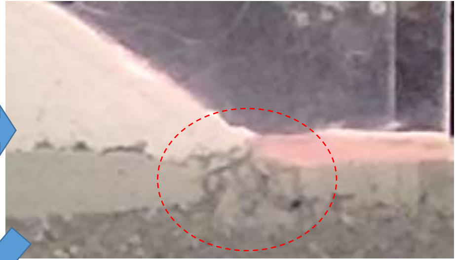
・ 480s, 噴砂発生, 対策工内に9号が流入
