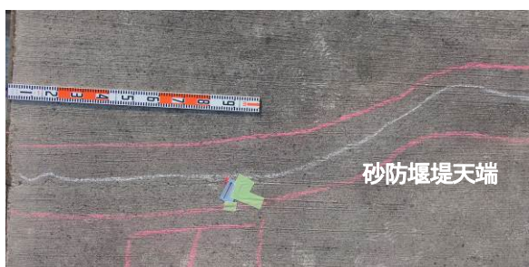
図-8 緊急詳細点検結果（砂防堰堤の近接撮影）
