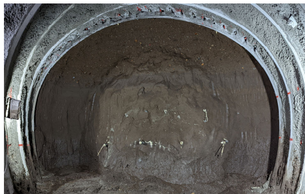
図-3 計測トンネル (Aトンネル)
