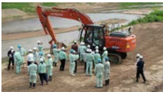
写真6 ICT施工現場での勉強会
