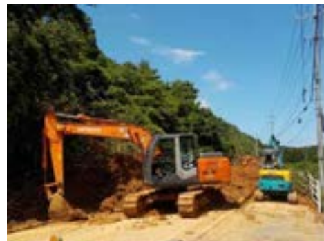
写真-2 令和3年災 道路啓開作業
