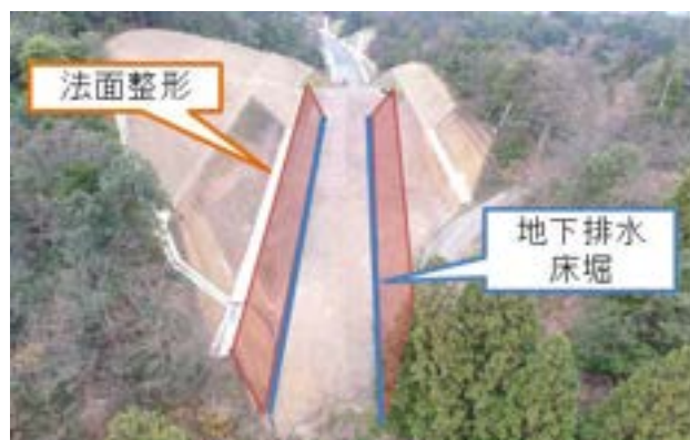
図 3-1 ICT活用工事実施箇所（岸本バイパス）
