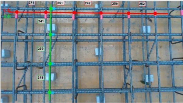
図-10 鉄筋の出来形自動検測システム
