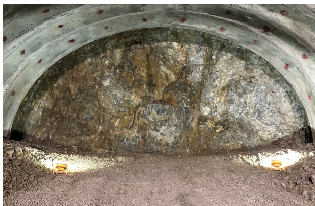
図-3 TD=400m付近切羽状況
