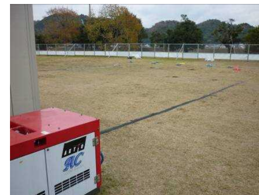
空気注入状況
