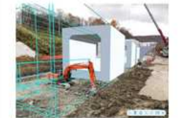
掘削作業時にARと比較
