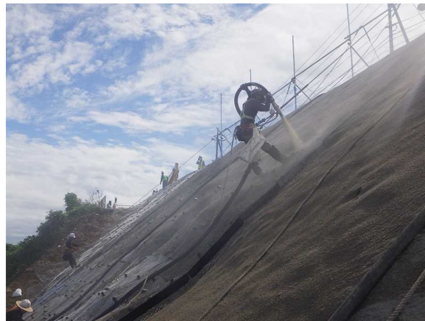
モルタル吹付 作業状況
