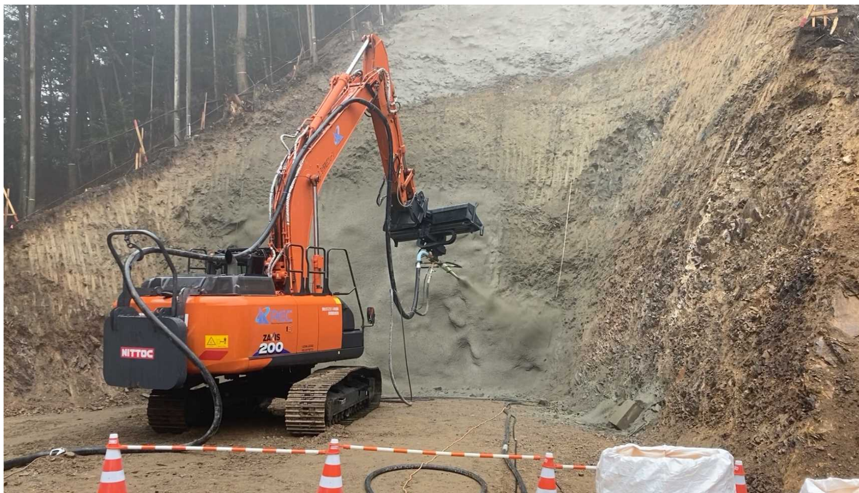
スロープセイバーの施工状況
