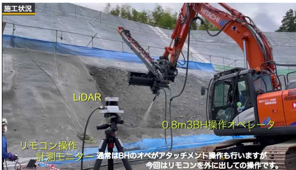
吹付状況(LiDARによるリアルタイム吹付厚計測)
