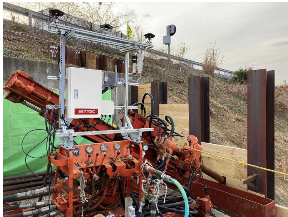
SGZAs搭載の削孔機によるアンカー工の施工
