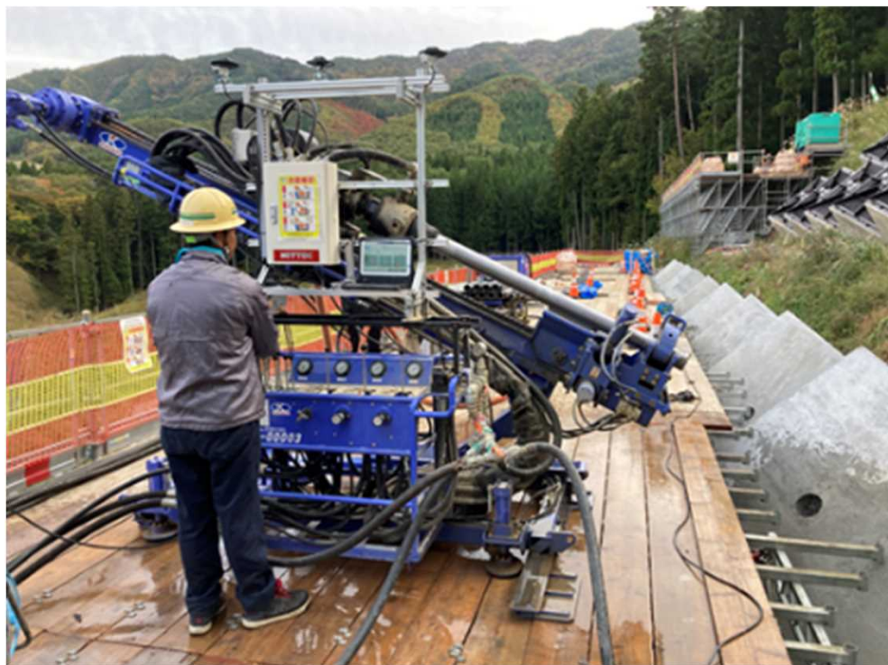
SGZAs搭載の削孔機によるアンカー工の施工
