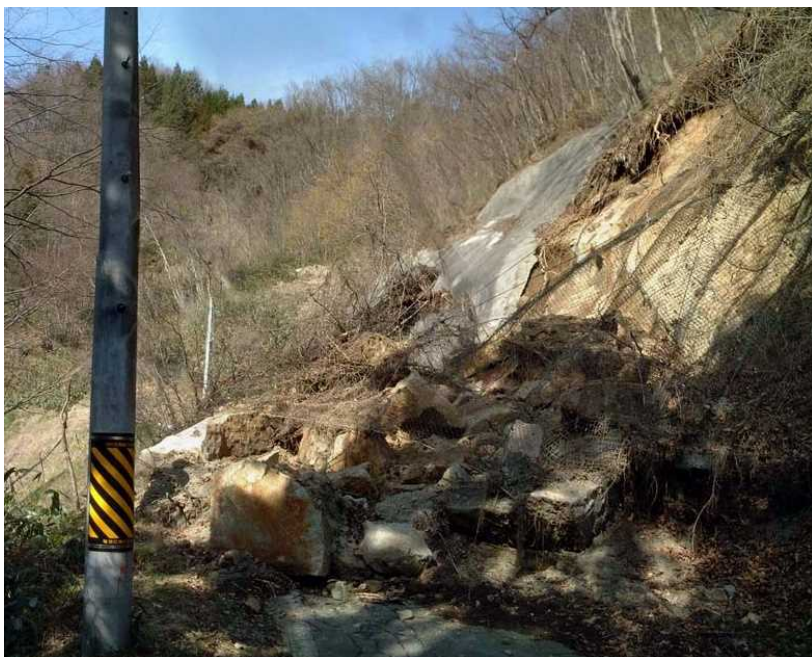
豪雨による斜面崩壊
