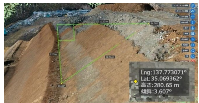
図-9 点群での盛土高さの確認
