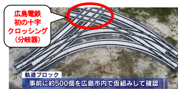
写真-5 仮設ヤードでの軌道ブロック仮組状況
