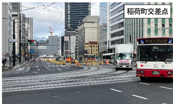
写真-1 軌道整備範囲（地上部）の交通状況（一例）
