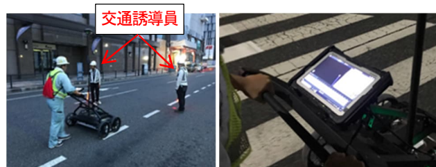
写真-2 探査状況
