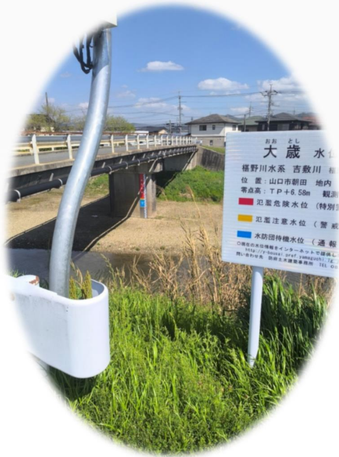
量水標と各水位の目安表の事例
