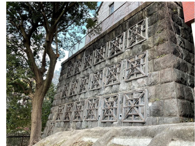
石積擁壁の補修事例
