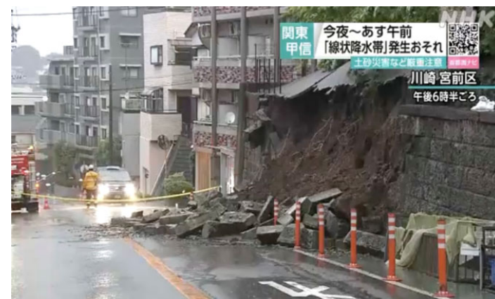
西洋式ブラフ擁壁崩壊 2023年川崎市宮前区ブラフ擁壁)
