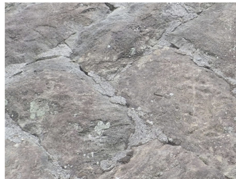
空石積擁壁の補修事例
