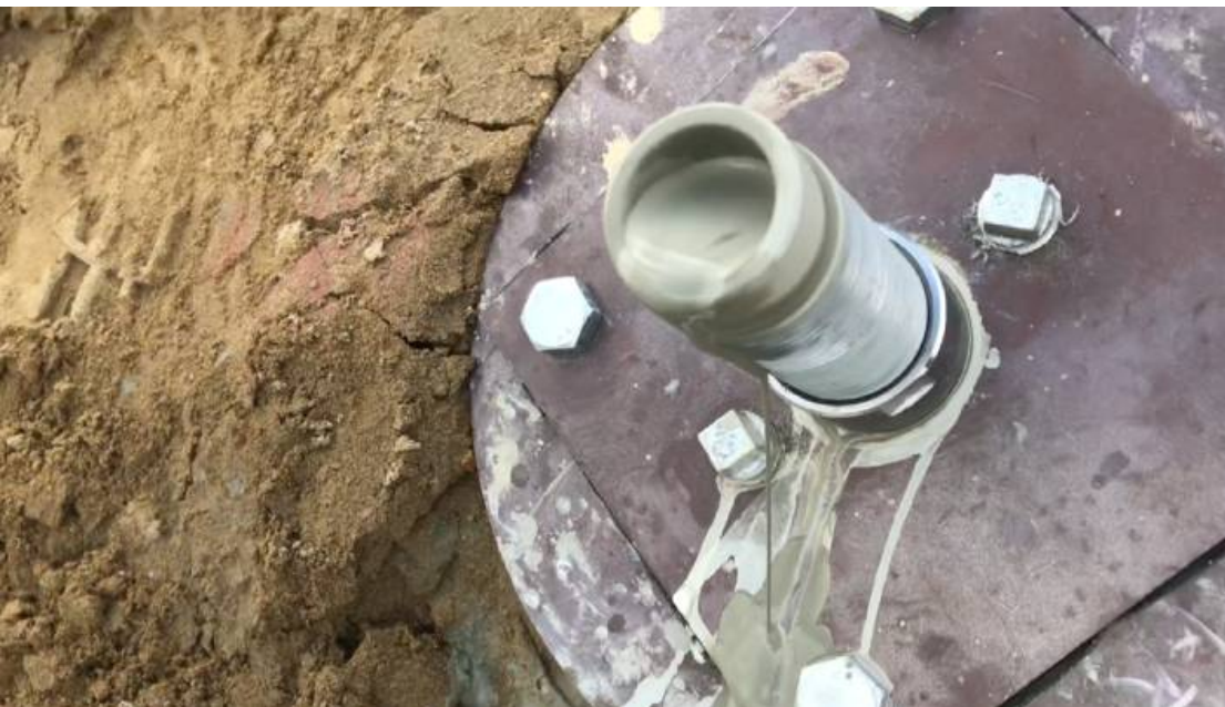
本工法の注入材 （加圧脱水無し）
