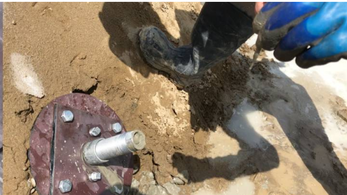
通常の注入材 （加圧脱水有り）
